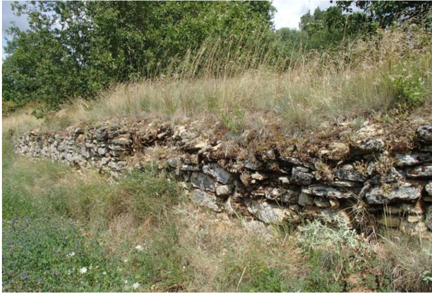
Muret de pierres sèches aux Moulins de Beaupuy, juillet 2014
