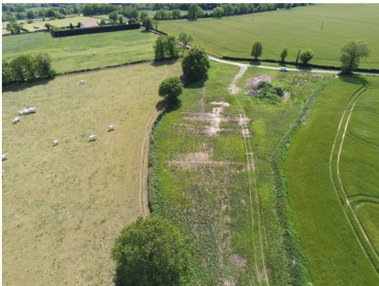
Photo 64: Vue (orientée sud) du délaissé du Plessis. On distingue bien les différentes parties à la couleur de la végétation (photo Y. Morizet)
