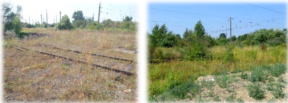
Figure 29 : vues de la friche ferroviaire en place sur CN8.
