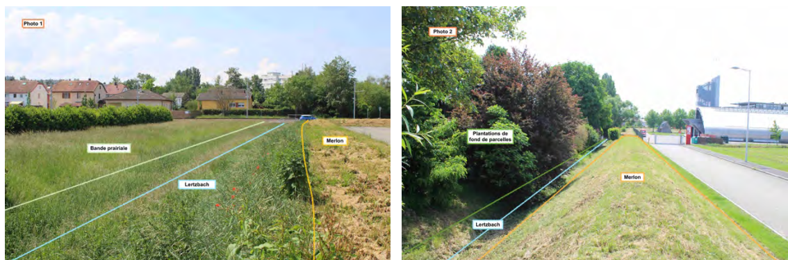
Figure 81 : vues du Lertzbach encadré par des merlons autour du SDIS. Saint-Louis, avril 2018.
