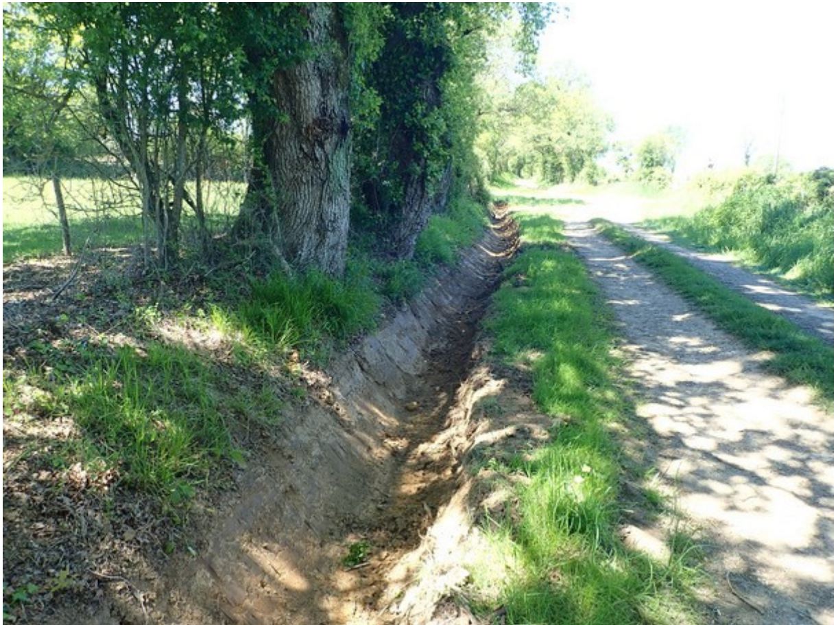
Photo 36: Fossé curé, secteur des Simeaux
