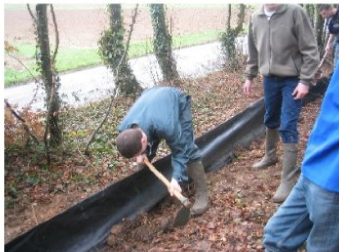
Installation d'un barrage temporaire dans la Somme © Picardie Nature
