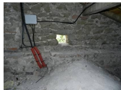
Figure 42 : ouverture dans la salle des voûtes de l'église de Poncins
