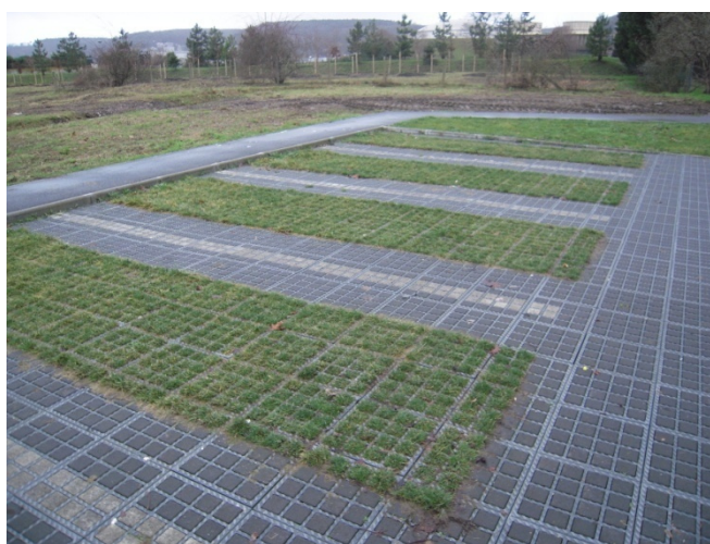
Figure 31 : Système de croisillons au niveau du parking Rue de la Mare
