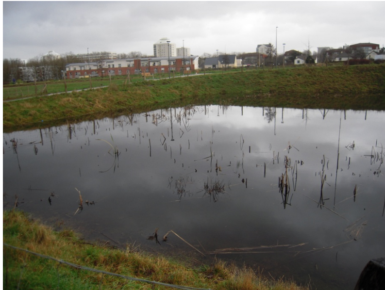
Figure 35 : Bassin de rétention proche du Bois Matisse
