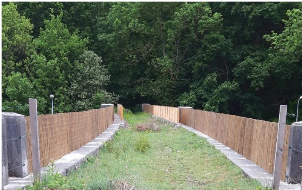
Photo 4 : photo du viaduc transformé en passage à faune
