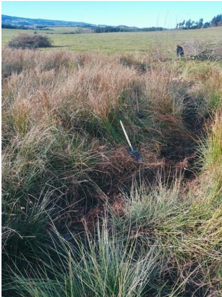
Mare périphérique (n°2) pendant travaux
