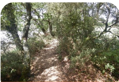
Chemins sur digue
