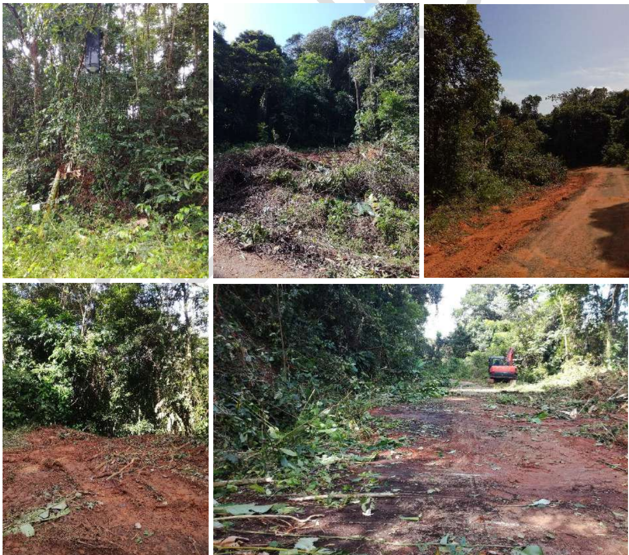
Figure 7 : travaux à la Montagne du Tigre. © Ombeline Sculfort.
