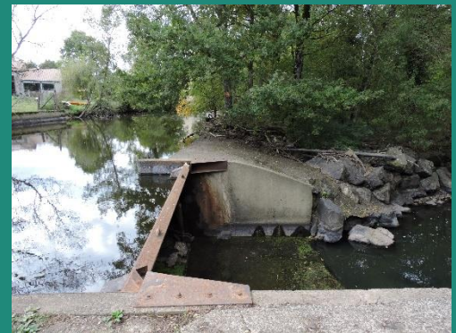
Ouvrage à Champagné, à l'Est de la commune
