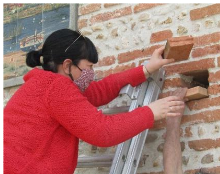
Figure 67. Obstruction partielle des trous de boulins
