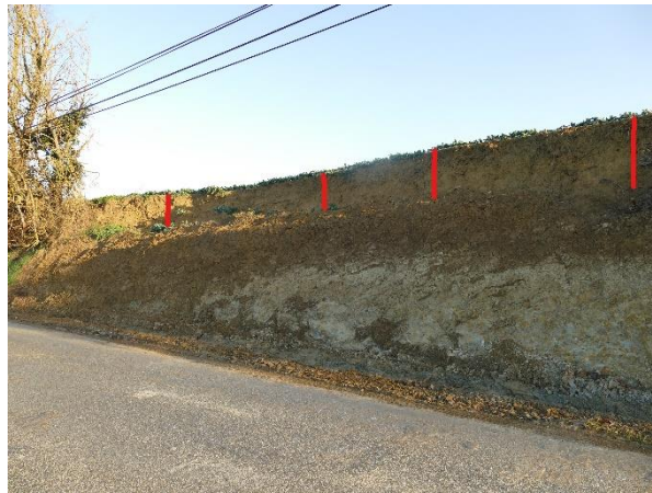
Figure 85. Erosion et ruissellement d'une parcelle agricole à Montastruc-la-Conseillère en 2023
