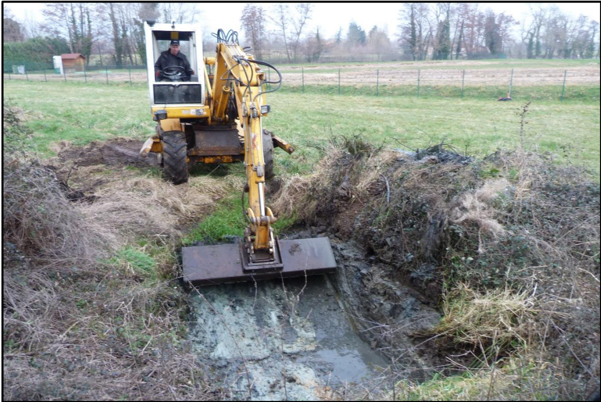
Figure 77 : Mare en cours de restauration © Bertrand Tranchand
