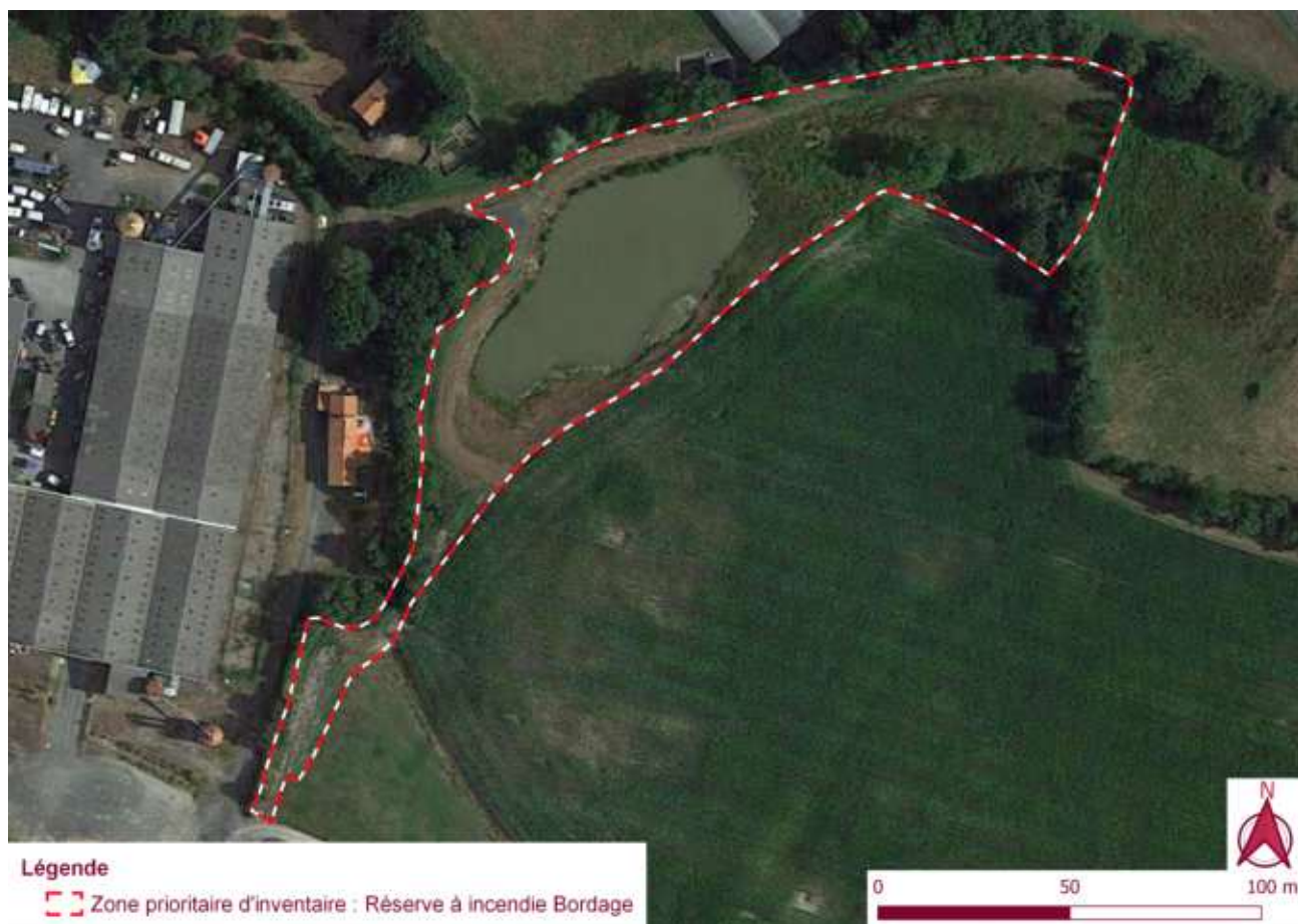
Figure 48 : vue aérienne de la réserve à incendie de Bordage
