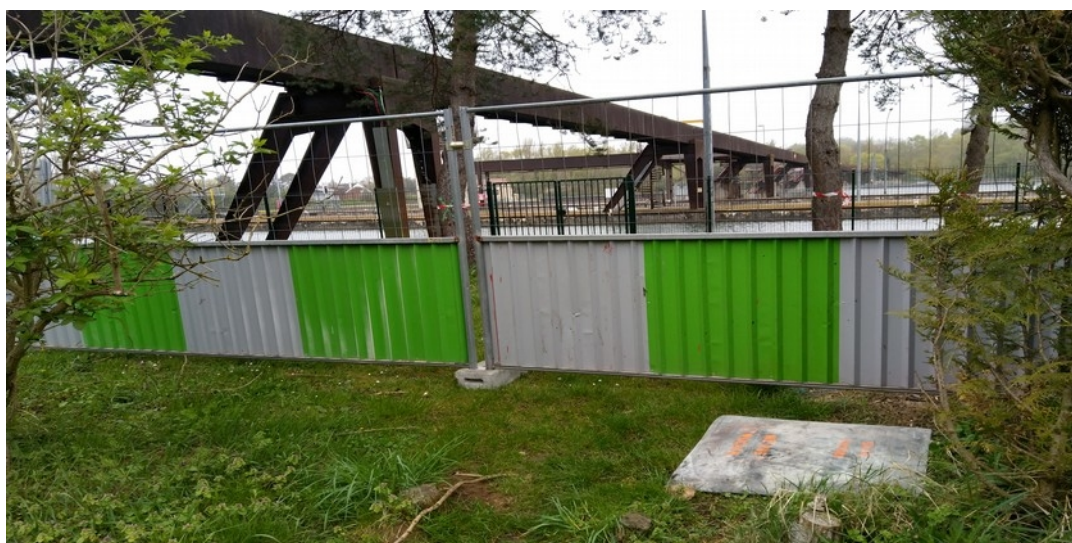
Illustration IV.2: Travaux à l'écluse.
