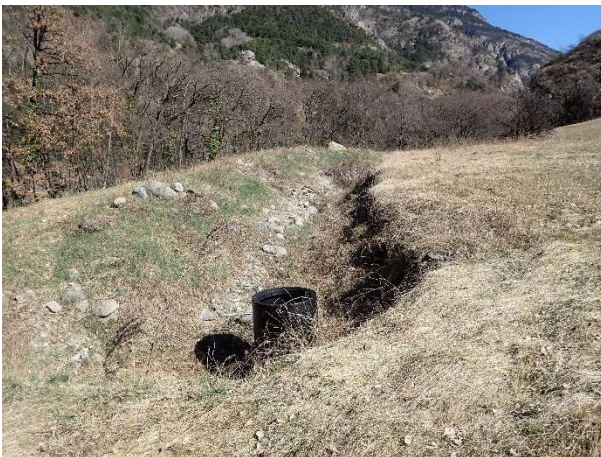
Fossé et regard en plastique en bas de la prairie
