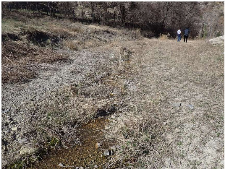
Source s'écoulant sur la desserte du lotissement
