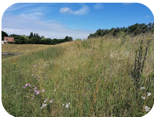
Figure 50 : Ilot refuge du bassin de Févretot
