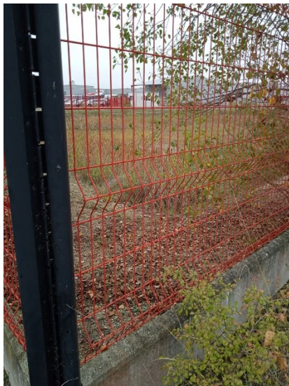
Figure 80. Les clôtures à soubassement (à gauche) ou à plis (à droite) limitent le déplacement de la faune. Les clôtures à plis sont parfois des pièges mortels pour les hérissons (photos prises hors site, ©L. Lecroq)
