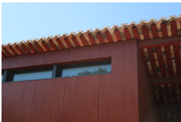
Figure 20. Toiture de la crèche, non accessible pour les chiroptères © C. Verot -CEN PACA, 2022
