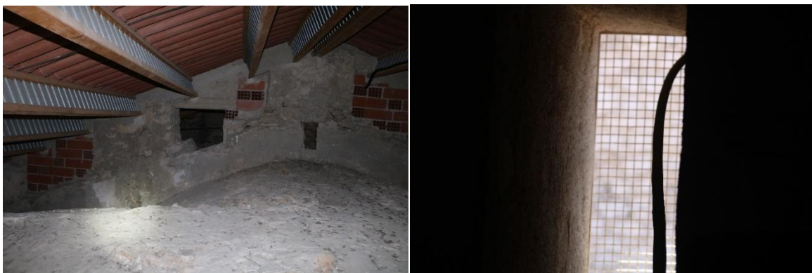
Figure 16. Comble de la collégiale Saint-Paul avec un accès grillagé inaccessible pour les chiroptères afin d'empêcher l'intrusion des pigeons © C. Verot -CEN PACA, 2022
