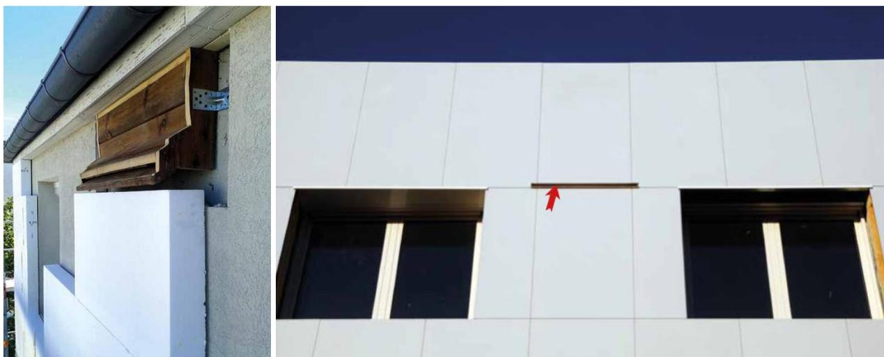
*Figure 7. Gîte inséré dans l'isolation thermique*
