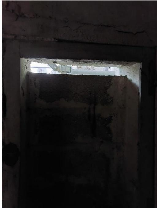
*Figure 2. Fenêtre murée présentant un interstice suffisant pour le passage des chiroptères.*
