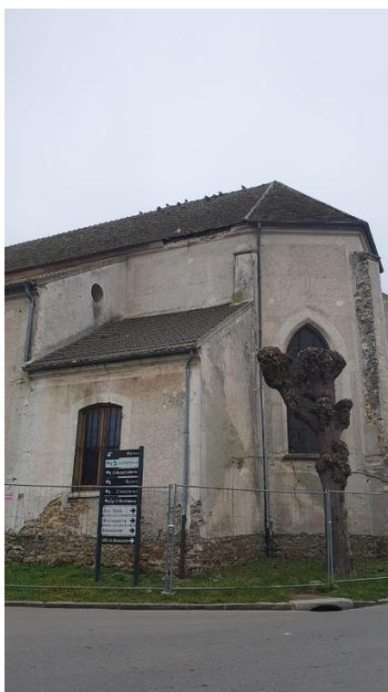
Figure 1. Partie de la corniche soutenant la toiture s'effondrant.
