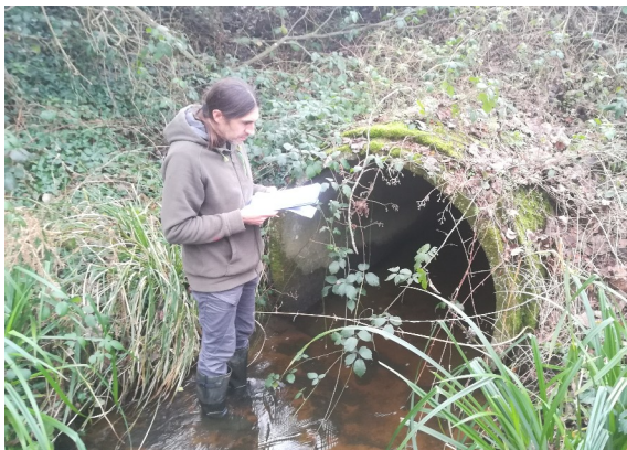
Diagnostic d'un ouvrage par le GMB
