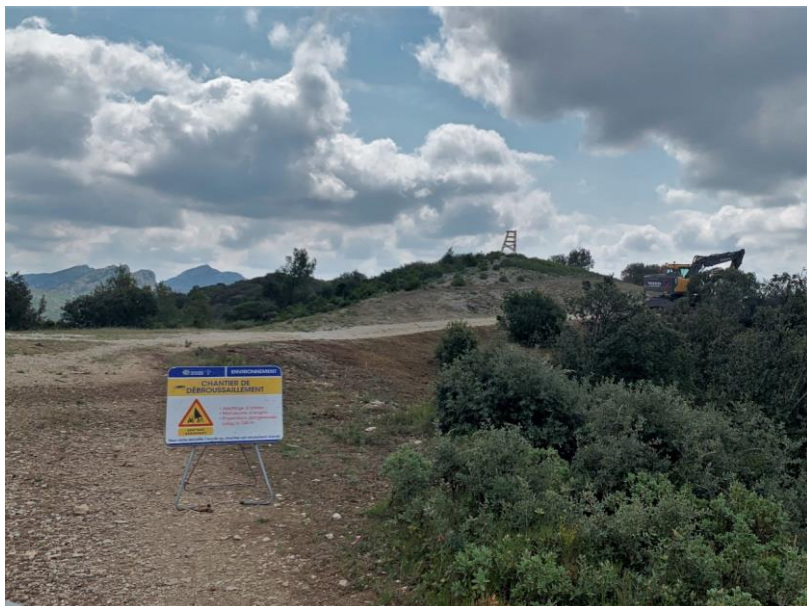
Exemple de chantier DFCI le 06/06/2023 sur la commune de Aureille. Ce type de chantier à cette période de l'année a des conséquences catastrophiques pour la nidification des oiseaux © LPO PACA
