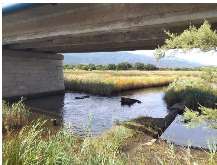
Figure 2 : Point 4 sous le pont de Figari
