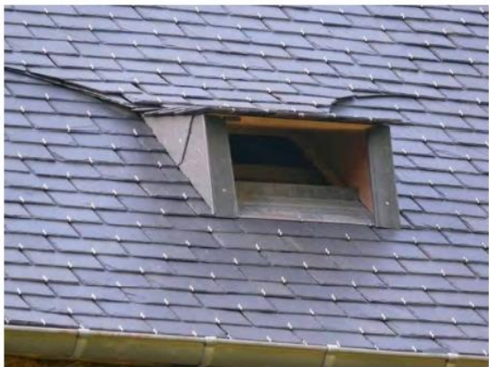
Figure 74 : Exemple d'une chiroptière dans une charpente
