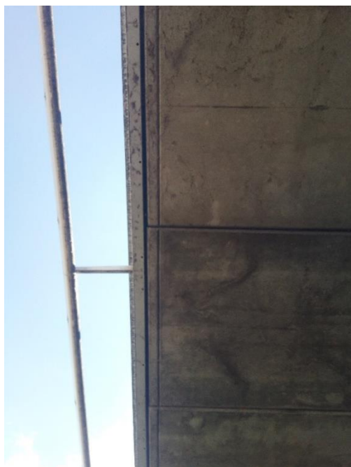
Figure 78 : Exemple de micro-gîte en-dessous du Pont de la Vendée à Tours (Cher)
