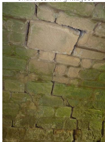
Pierre décelée de la voute et différentes anfractuosités
