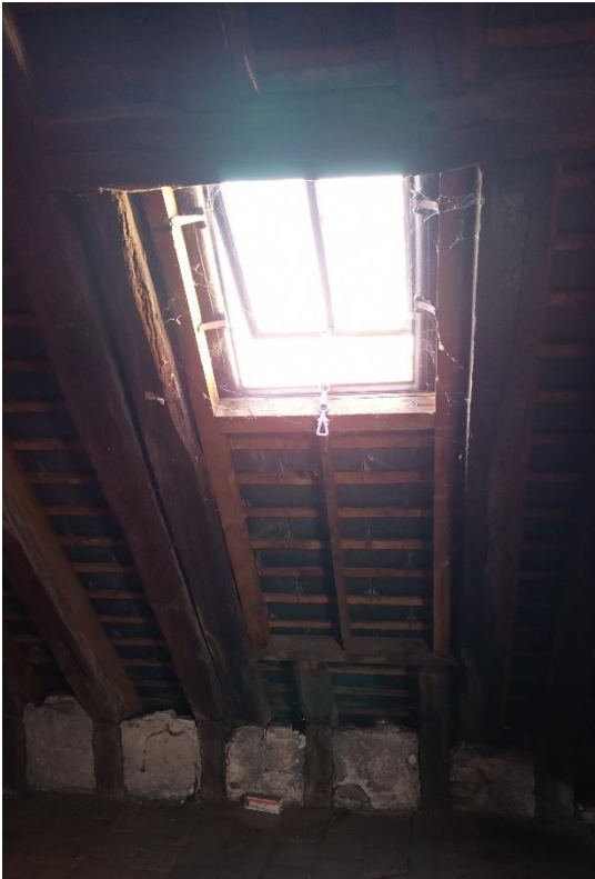
Figure 73 : Une ouverture des combles de l'école Paul Louis Courier, compatible avec un aménagement tabatière
