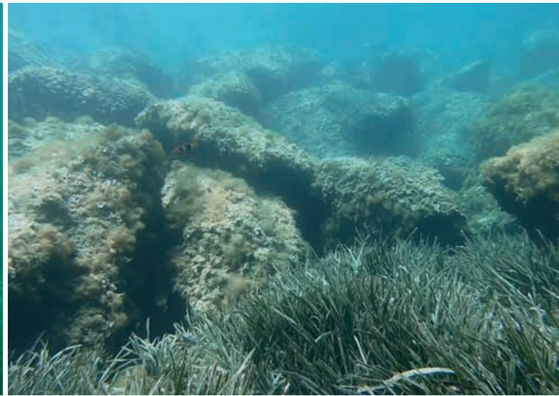
Blocs rocheux artificiels avec strate arbustive et limite supérieure de l'herbier de Posidonie - Saint-Jean-Cap-Ferrat est Digue du port de Saint-Jean-Cap-Ferrat
