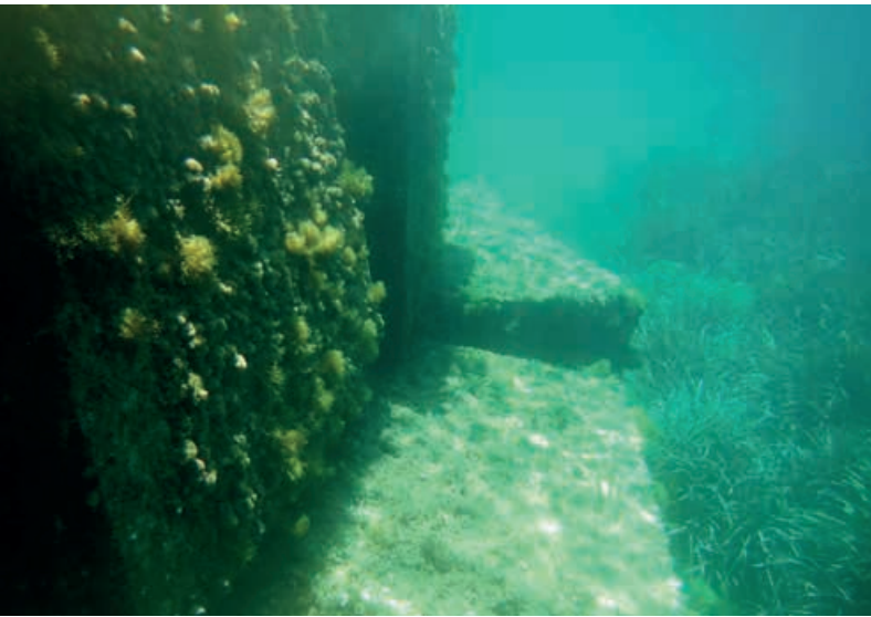
Blocs rocheux artificiels cubiques et herbier de Posidonie
