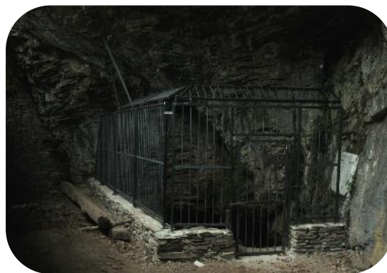
Figure 4: Grille protégeant l'entrée de la Grotte du Gaougnas
