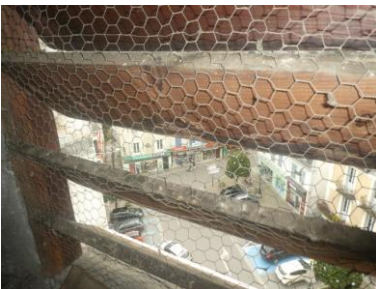
Vue entre les abats-son grillagées du clocher, le 7 janvier 2022 © H. Dupuy
