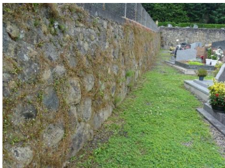
Vieux mur du cimetière, le 8 juin 2022 © R. Lattuga
