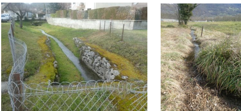
Sections de canaux plutôt défavorable au Campagnol amphibie à gauche, et favorable à droite (en eau, avec une végétation suffisante pour évoluer à couvert et s'alimenter), le 6 février 2022 © H. Dupuy
