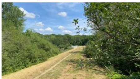
Magny 4 : Chemin de digue / etang
